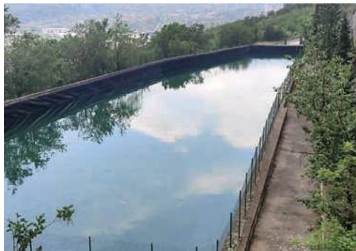
Vasca di accumulo e compenso 'Cerrele' per una estensione di 2.200 mq con capacità di carico di oltre 13.000 mc
