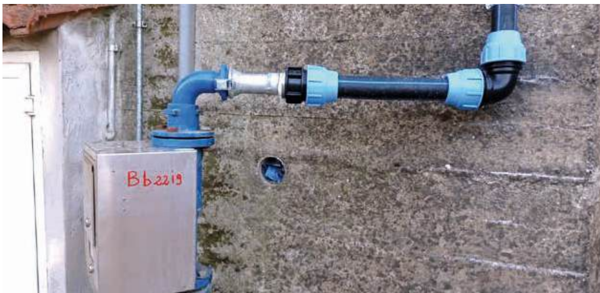
Impianto di allacciamento idrico con valvola e raccordi per la distribuzione dell'acqua irrigua.
