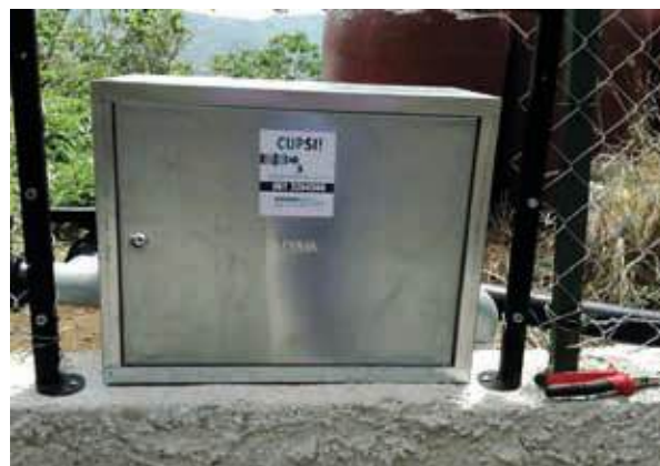
Posizionamento contaltri per nuovo allaccio alla rete irrigua
