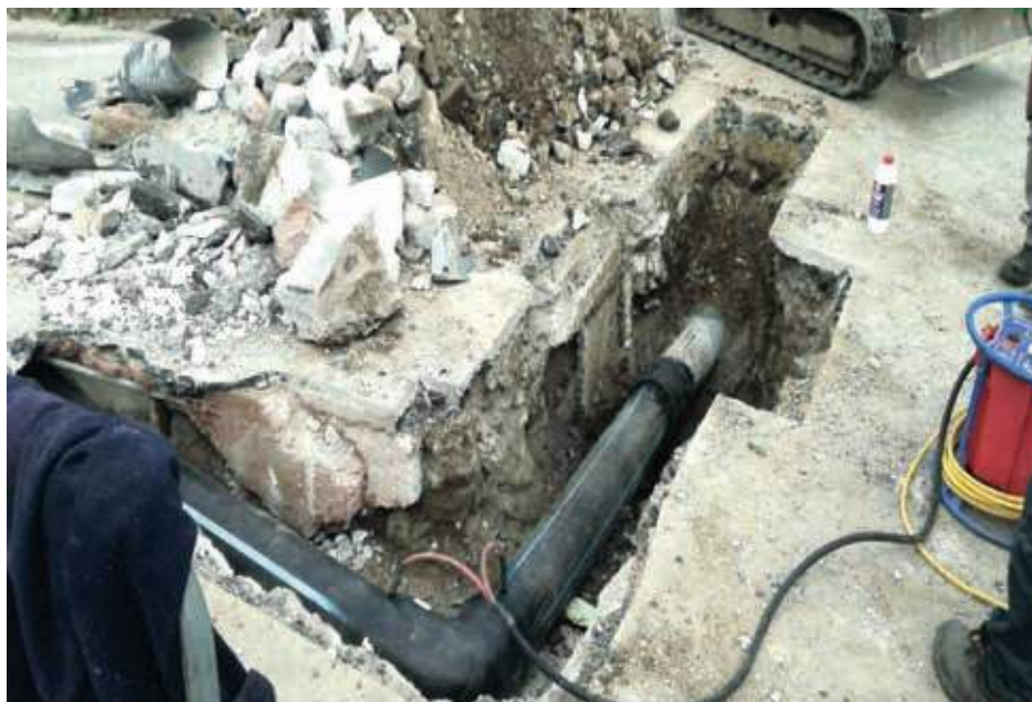
Installazione condotta irrigua in PeAD con saldatura a termofusione
