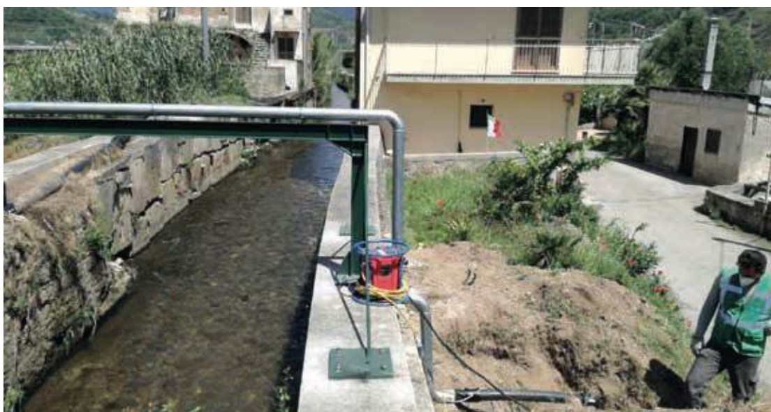
Realizzazione di ponte tubo sul torrente Casarzano
