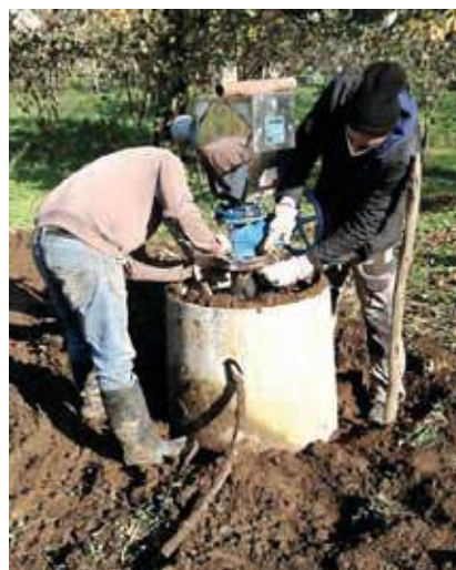
Manutenzione Idrante
