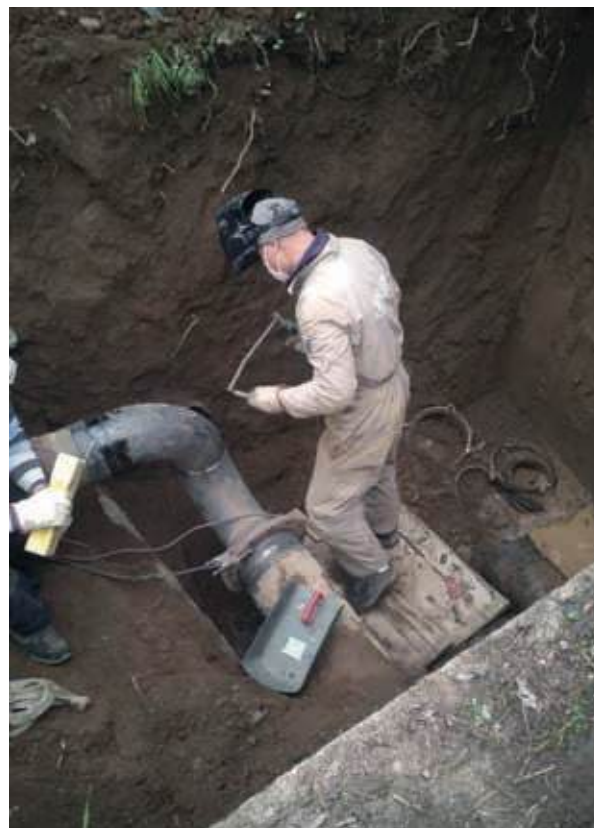
Sostituzione condotta in acciaio con saldatura ad arco elettrico
