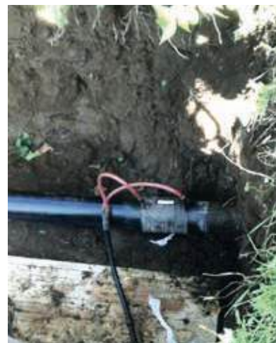
Installazione condotta irrigua in PeAD con saldatura a termofusione
