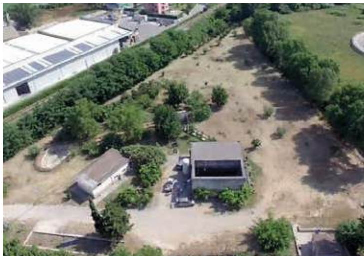
Centrale di Sollevamento Paludi costituita attualmente da una vasca di carico e n.3 pozzi di emungimento per un totale di 90 l/s
