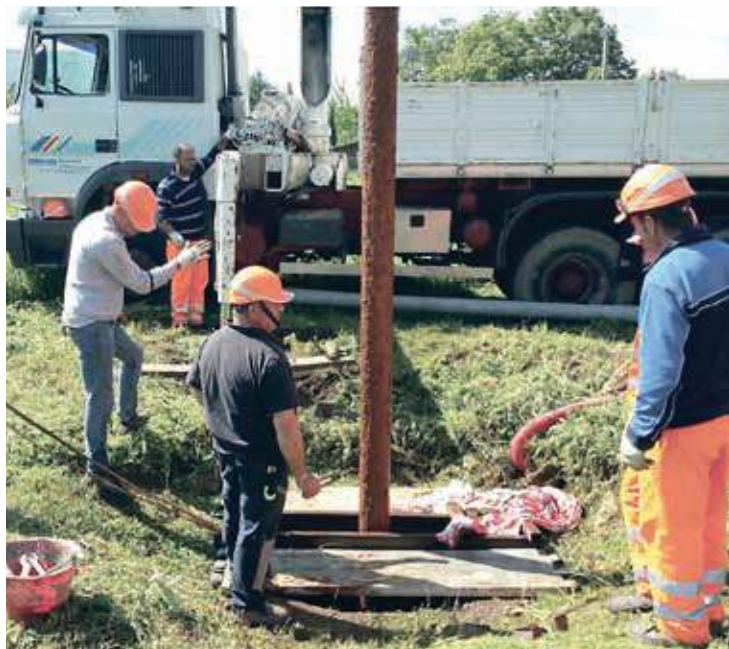
Eduzione elettropompa per manutenzione ordinaria
