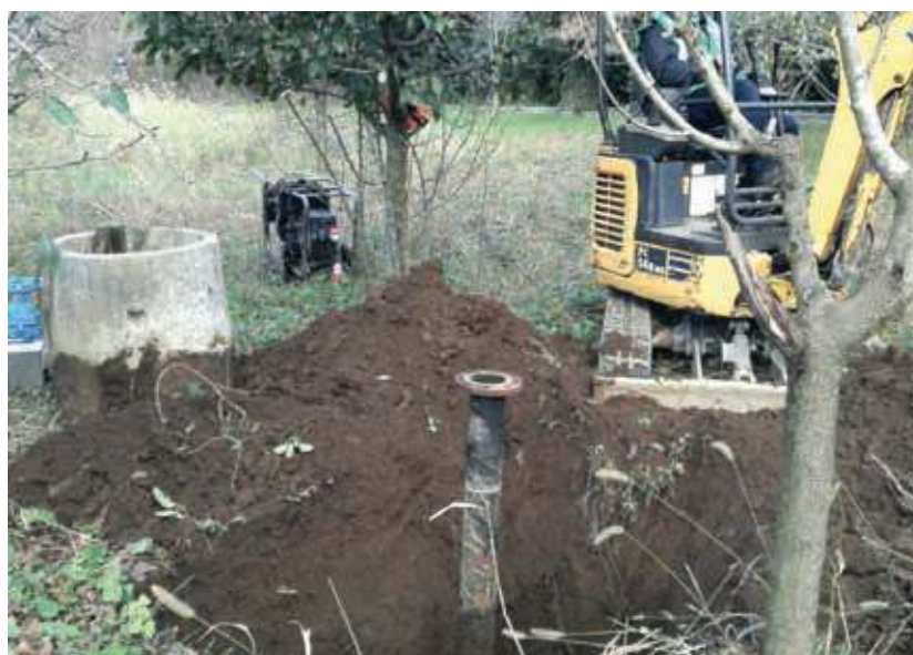
Installazione nuovo idrante
