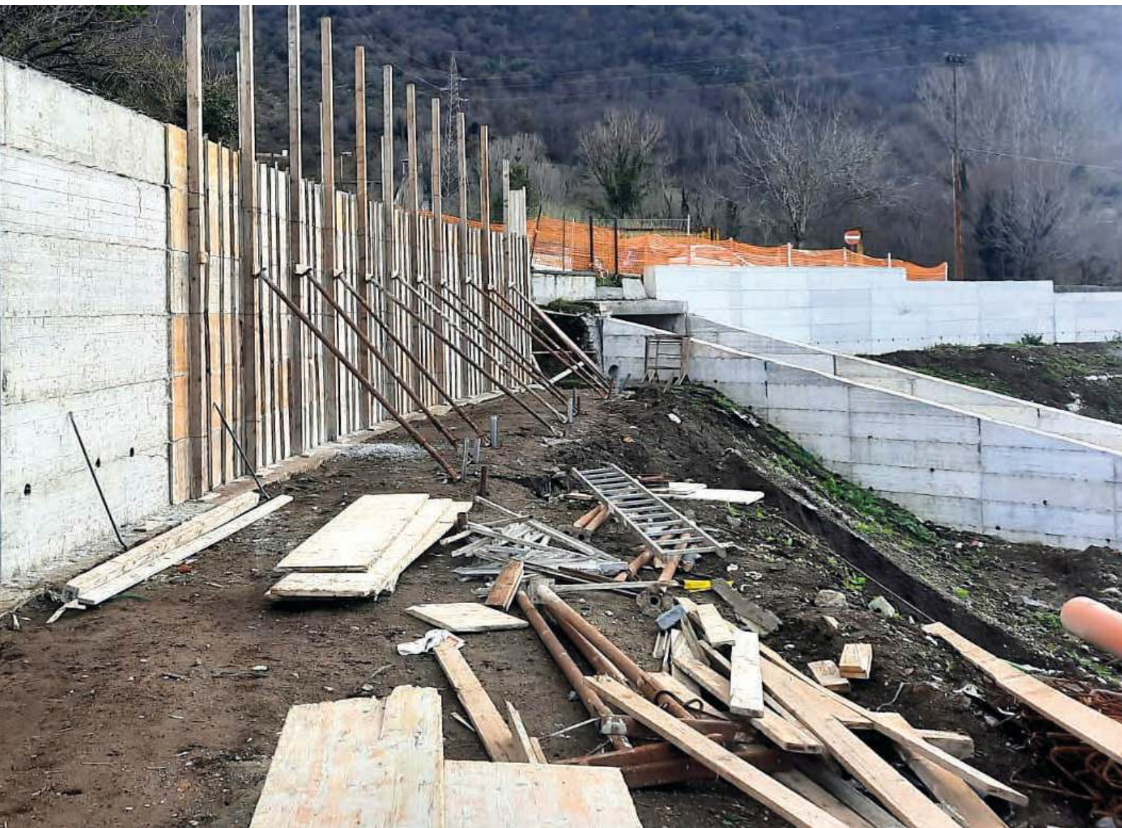
Vasca Valesana durante la costruzione dei muri di sostegno perimetrali febbraio 2024
