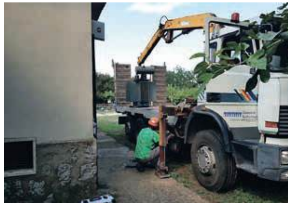
Sostituzione trasformatore MT/BT
