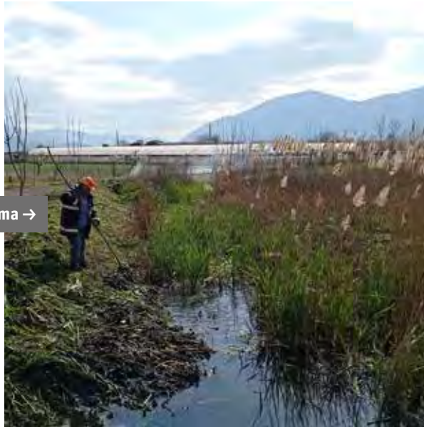
Canale San Mauro - Comune di San Marzano sul Sarno (tratto finale) Diserbo meccanico con trattore decespugliatore del fondo alveo e delle sponde
