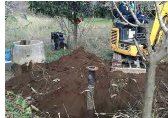
Installazione nuovo idrante
