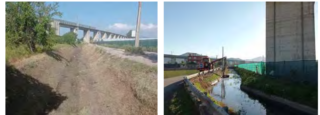
Canale Fosso Imperatore - Comuni di Nocera Inferiore, Pagani, San Valentino Torio e San Marzano sul Sarno Lavori di diserbo manuale e meccanico delle sponde e del fondo alveo
