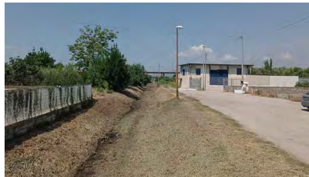
Canale Fosso Imperatore - Comuni di Nocera Inferiore, Pagani, San Valentino Torio e San Marzano sul Sarno Lavori di diserbo manuale e meccanico delle sponde e del fondo alveo
