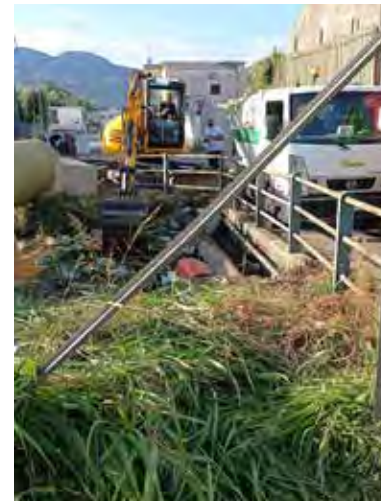
Canale San Tommaso - Comune di Scafati (Via G. Ferraris - Agosto 2022) Rimozione dei rifiuti abbandonati abusivamente in alveo e trasporto presso impianto autorizzato
