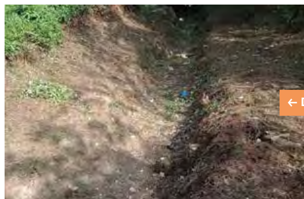
Vallone Bagnara – Comune di Nocera Superiore Lavori di diserbo manuale del fondo alveo e delle sponde Ripristino sezioni idrauliche con risagomatura sponde e fondo alveo con mezzi meccanici
