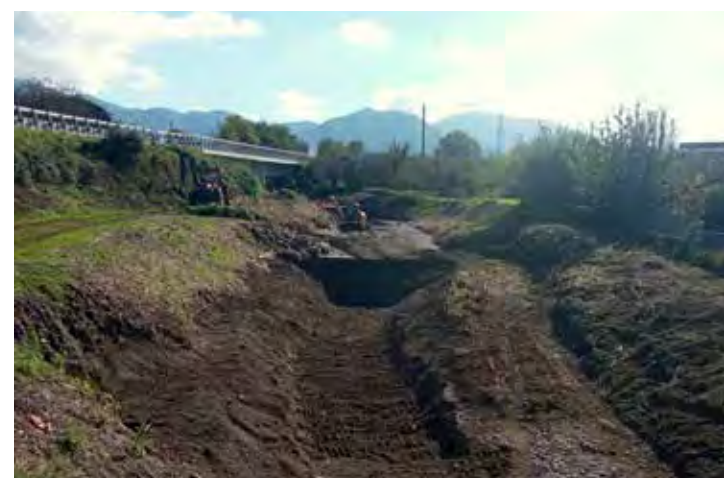
Torrente Calvagnola – Comune di Fisciano Lavori di diserbo meccanico e manuale del fondo alveo e delle sponde Ripristino sezioni idrauliche con risagomatura sponde e fondo alveo con mezzi meccanici
