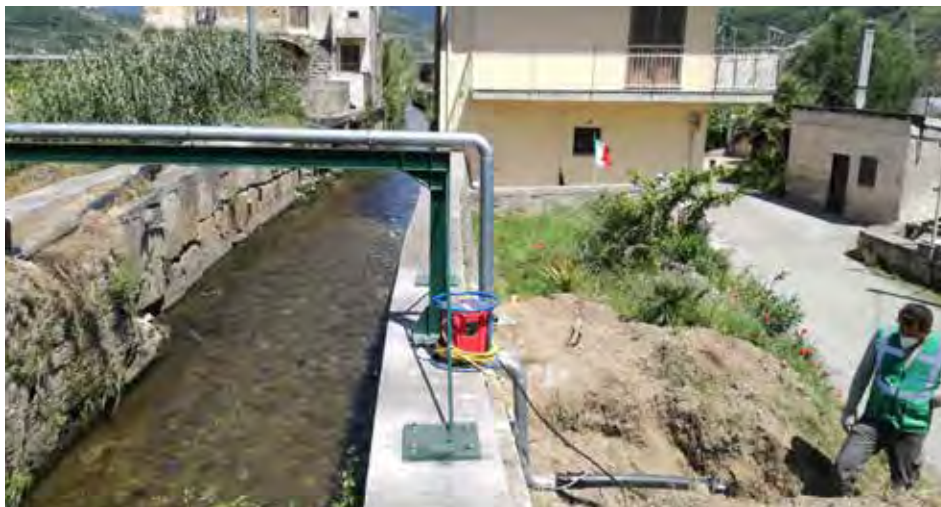
Realizzazione di ponte tubo sul torrente Casarzano
