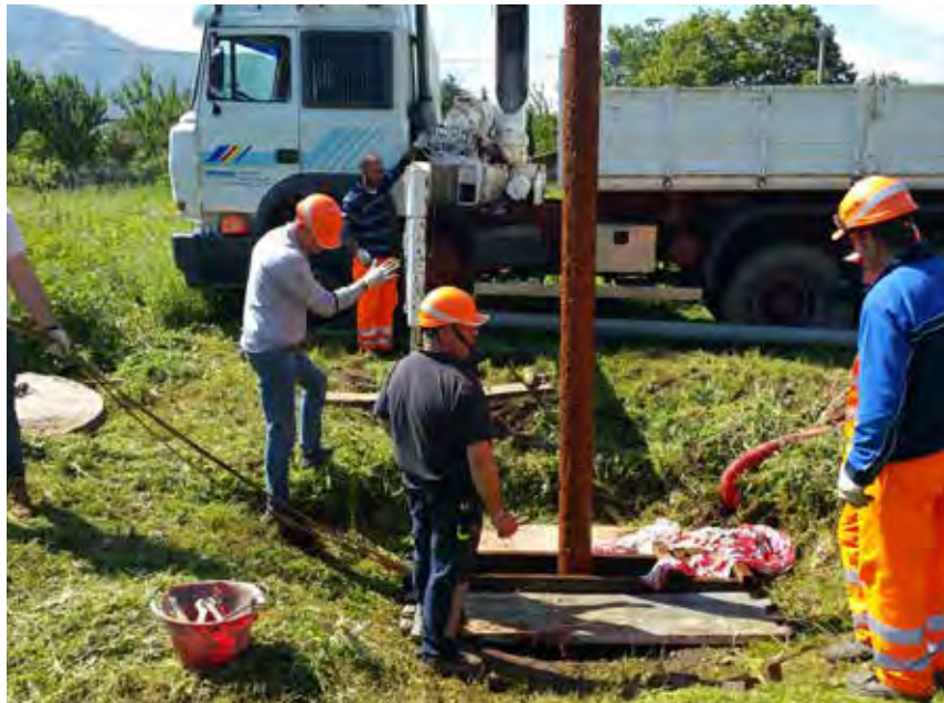
Eduzione elettropompa per manutenzione ordinaria
