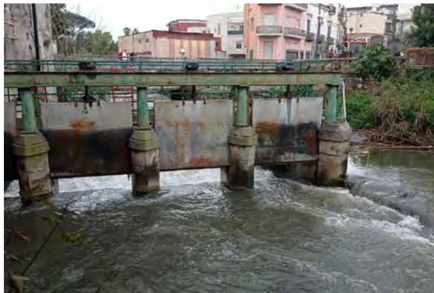
Presidio idraulico complesso delle paratoie sul fiume Sarno - Comune di Scafati Interventi periodici di disostruzione a tutela della pubblica incolumità
