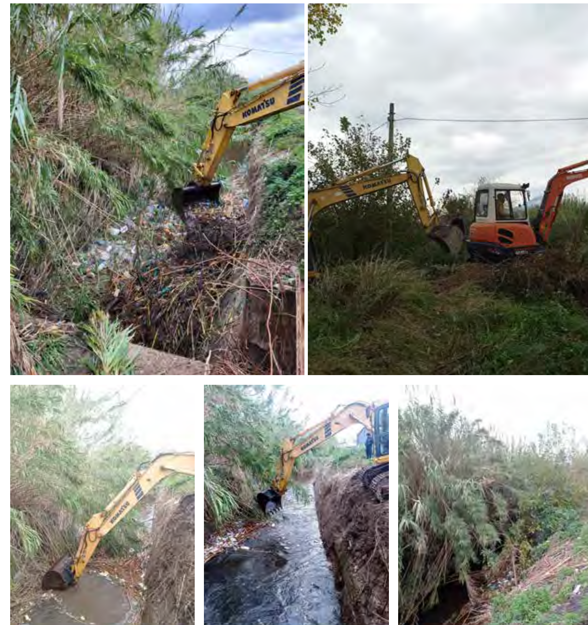
Alveo Comune Nocerino - Comune di Pagani (Via Filettine) Lavori urgenti per il ripristino dell'efficienza idraulica Rimozione dei rifiuti abbandonati abusivamente in alveo
