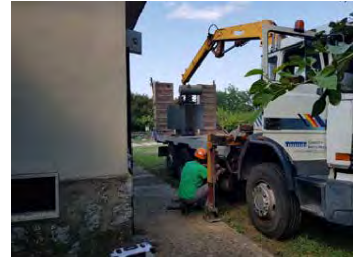
Sostituzione trasformatore MT/BT
