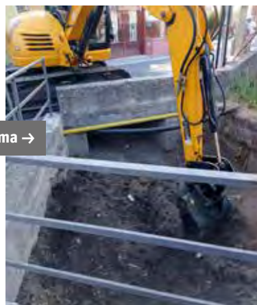
Canale dei Mulini – Comune di Castel San Giorgio Lavori di diserbo manuale del fondo alveo e delle sponde Ripristino della sezione idraulica e risagomatura fondo con mezzi meccanici
