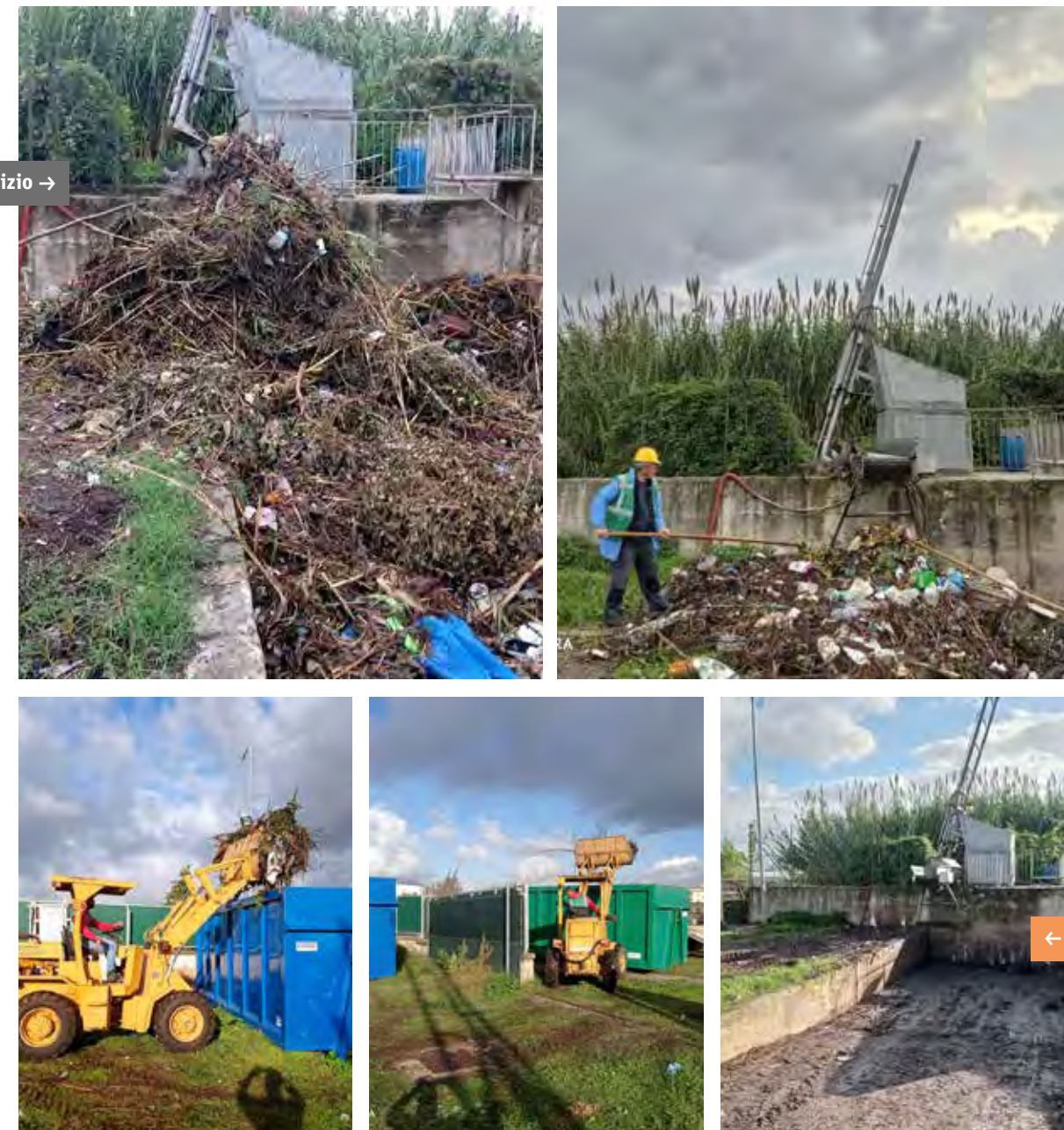
Controfosso Destro del fiume Sarno - Comune di Scafati Manufatto di Presidio idraulico: sgrigliatore meccanico a tutela della botte a sifone Intercettazione e smaltimento dei rifiuti
