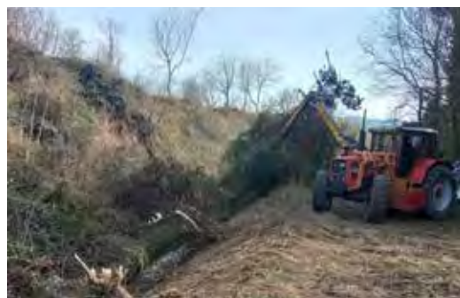
Canale Lenze – Fisciano Lavori di sfalcio meccanico e ripristino della sezione idraulica
