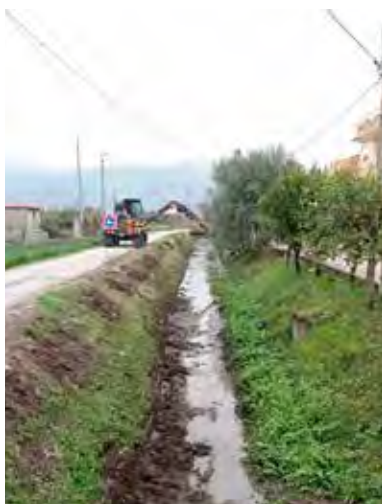
Canale Fosso Imperatore - Comuni di Nocera Inferiore, Pagani, San Valentino Torio e San Marzano sul Sarno Lavori di diserbo manuale e meccanico delle sponde e del fondo alveo
