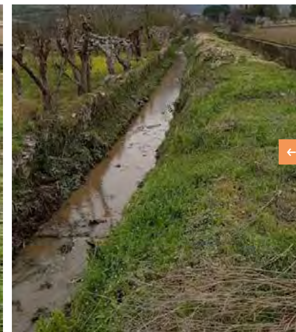
Canale Vietri – Comune di Montoro Lavori di diserbo meccanico e manuale del fondo alveo e delle sponde Ripristino sezioni idrauliche con risagomatura sponde e fondo alveo con mezzi meccanici
