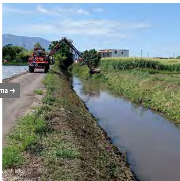
Canale Contofosso Destro del fiume Sarno - Comune di Scafati Lavori di diserbo manuale e meccanico delle sponde e del fondo alveo
