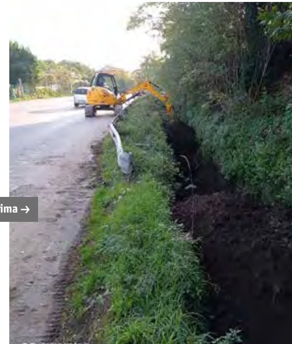
Canale Coscia – Comune di Mercato San Severino Lavori di diserbo manuale del fondo alveo Ripristino sezioni idrauliche con mezzi meccanici
