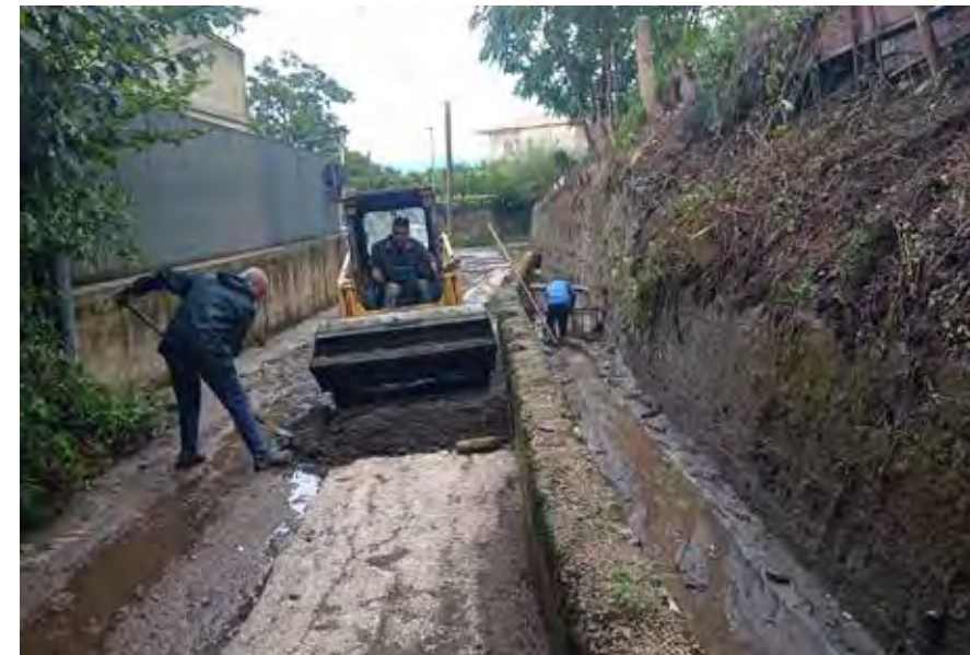
Canale Cottimo Superiore - Comune di Sant'Antonio Abate / Lettere Lavoro con mezzi meccanici per il ripristino dell'officiosità idraulica
