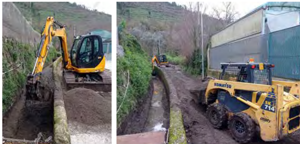
Canale Cottimo Superiore - Comune di Sant'Antonio Abate / Lettere Lavoro con mezzi meccanici per il ripristino dell'officiosità idraulica
