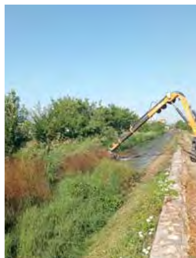
Canale Fosso Imperatore - Comuni di Nocera Inferiore, Pagani, San Valentino Torio e San Marzano sul Sarno Lavori di diserbo manuale e meccanico delle sponde e del fondo alveo
