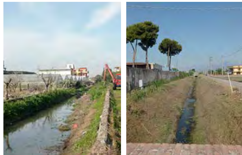
Canale Fosso Imperatore - Comuni di Nocera Inferiore, Pagani, San Valentino Torio e San Marzano sul Sarno Lavori di diserbo manuale e meccanico delle sponde e del fondo alveo
