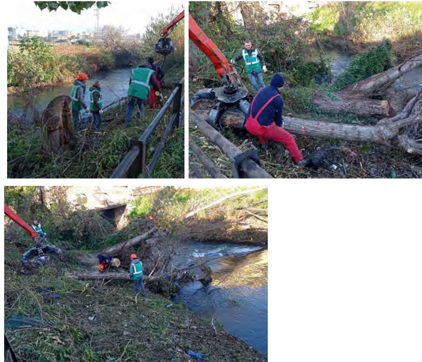
Fiume Sarno - Comune di Pompei Rimozione ostacoli al libero deflusso delle acque Taglio alberi, pulizia delle aree di pertinenza , raccolta e trasporto materiale residuo
