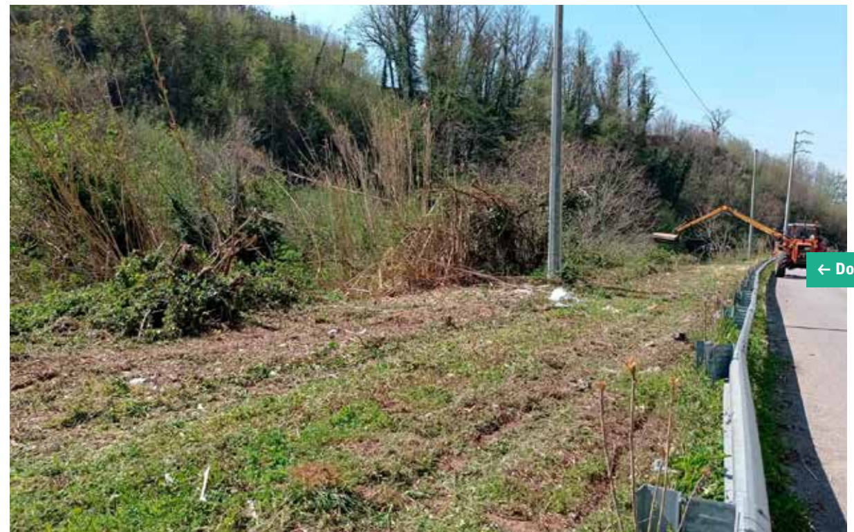
Torrente San Rocco - Comune di Fisciano Lavoro di sfalcio meccanico con trattore munito di braccio trinciante
