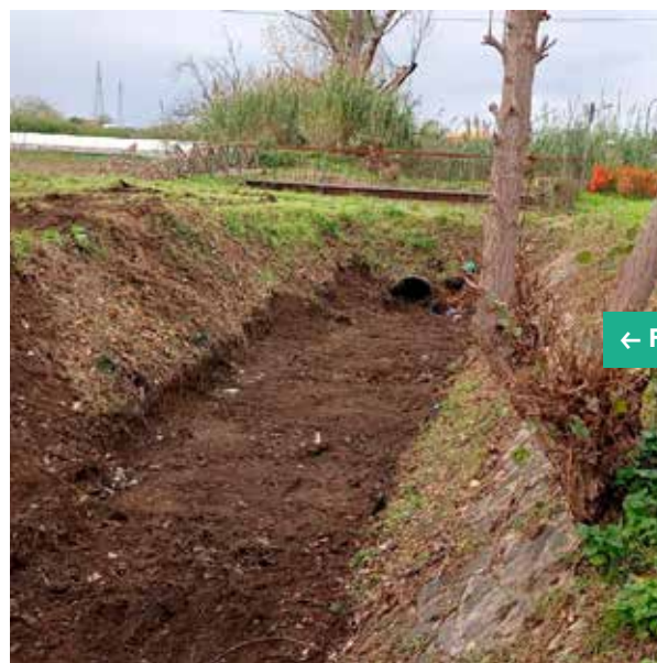
Canale Bottaro (tratto Via Stabiana) - Comune di Pompei Lavoro di sfalcio manuale e meccanico della vegetazione nel fondo e sulle sponde Recupero, rimozione e trasporto in impianto autorizzato e/o discarica di rifiuti indifferenziati
