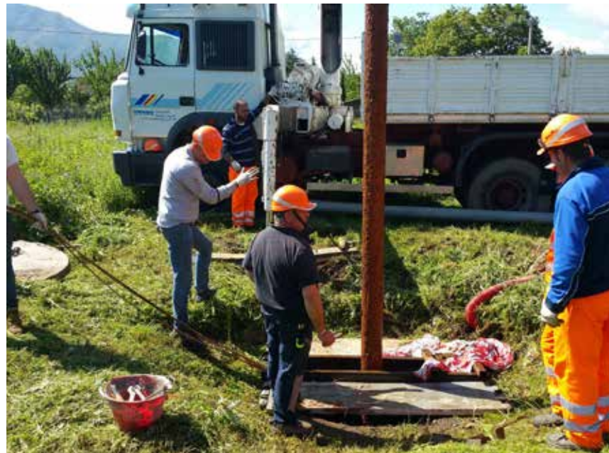
Eduzione elettropompa per manutenzione ordinaria
