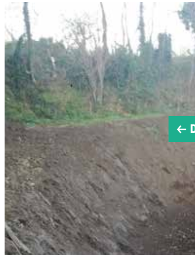
Vasca Coscia - Comune di Mercato San Severino Ripristino sezione idraulica con risagomatura sponde e fondo alveo con mezzi meccanici
