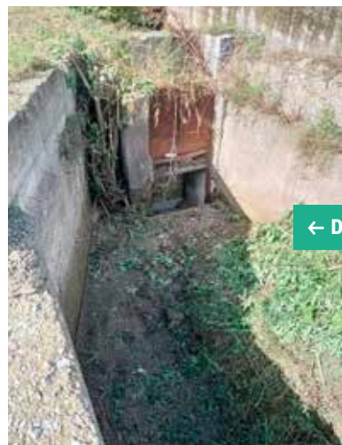
Canale Zanardelli - Comune di Roccapiemonte Diserbo meccanico e ripristino sezione idraulica con escavatore
