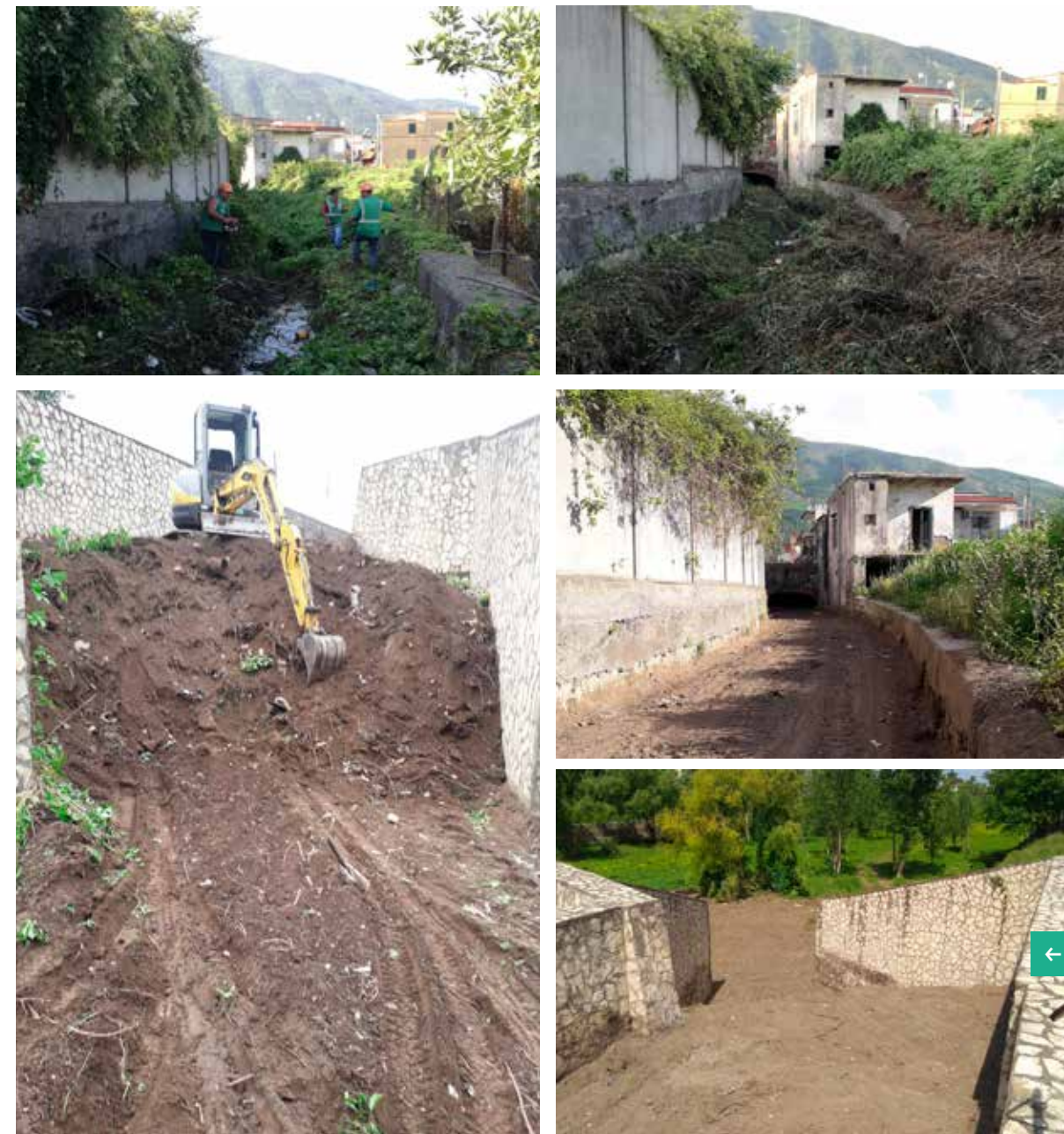
Collettore Santa Maria delle Grazie (tratto finale) - Comune di Angri Diserbo manuale del fondo alveo Ripristino sezioni idrauliche con rimozione, trasporto e conferimento in impianto autorizzato dei fanghi
