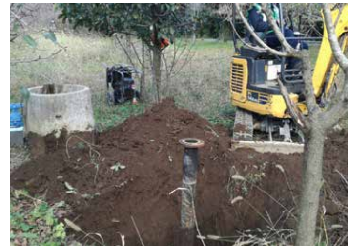
Installazione nuovo idrante
