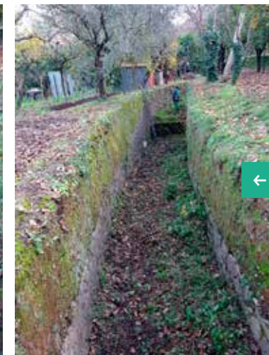
Collettore Pareti - Comune di Nocera Superiore Lavoro di sfalcio manuale della vegetazione nel fondo alveo
