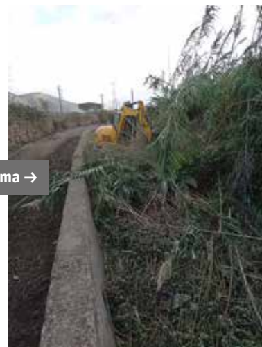
Canale Zanardelli - Comune di Roccapiemonte Diserbo meccanico e ripristino sezione idraulica con escavatore
