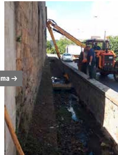
Canale Pietra Perciata - Comune di Castel San Giorgio Lavoro di sfalcio meccanico con trattore munito di braccio trinciante
