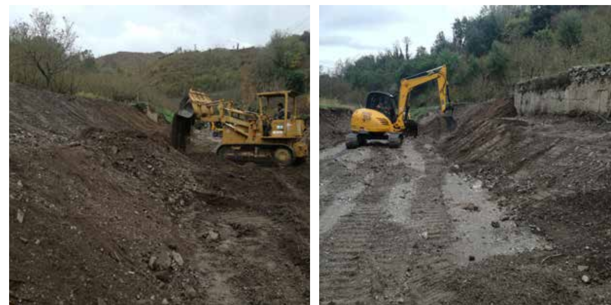
Torrente Calvagnola - Comune di Fisciano Ripristino sezioni idrauliche con risagomatura sponde e fondo alveo con mezzi meccanici
