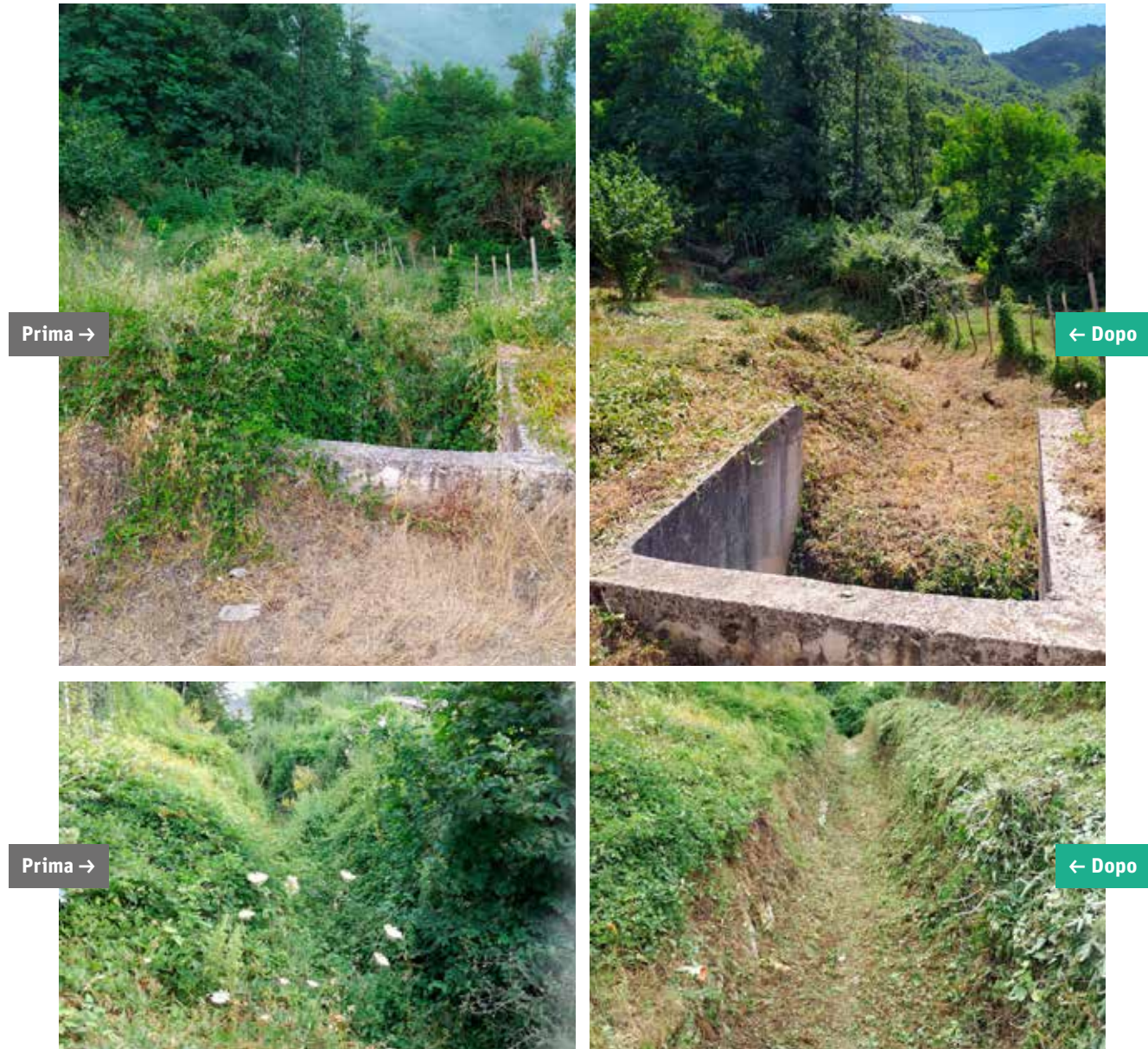
Vallone Incoronata - Comune di Montoro Lavoro di sfalcio manuale e meccanico del fondo alveo e delle sponde
