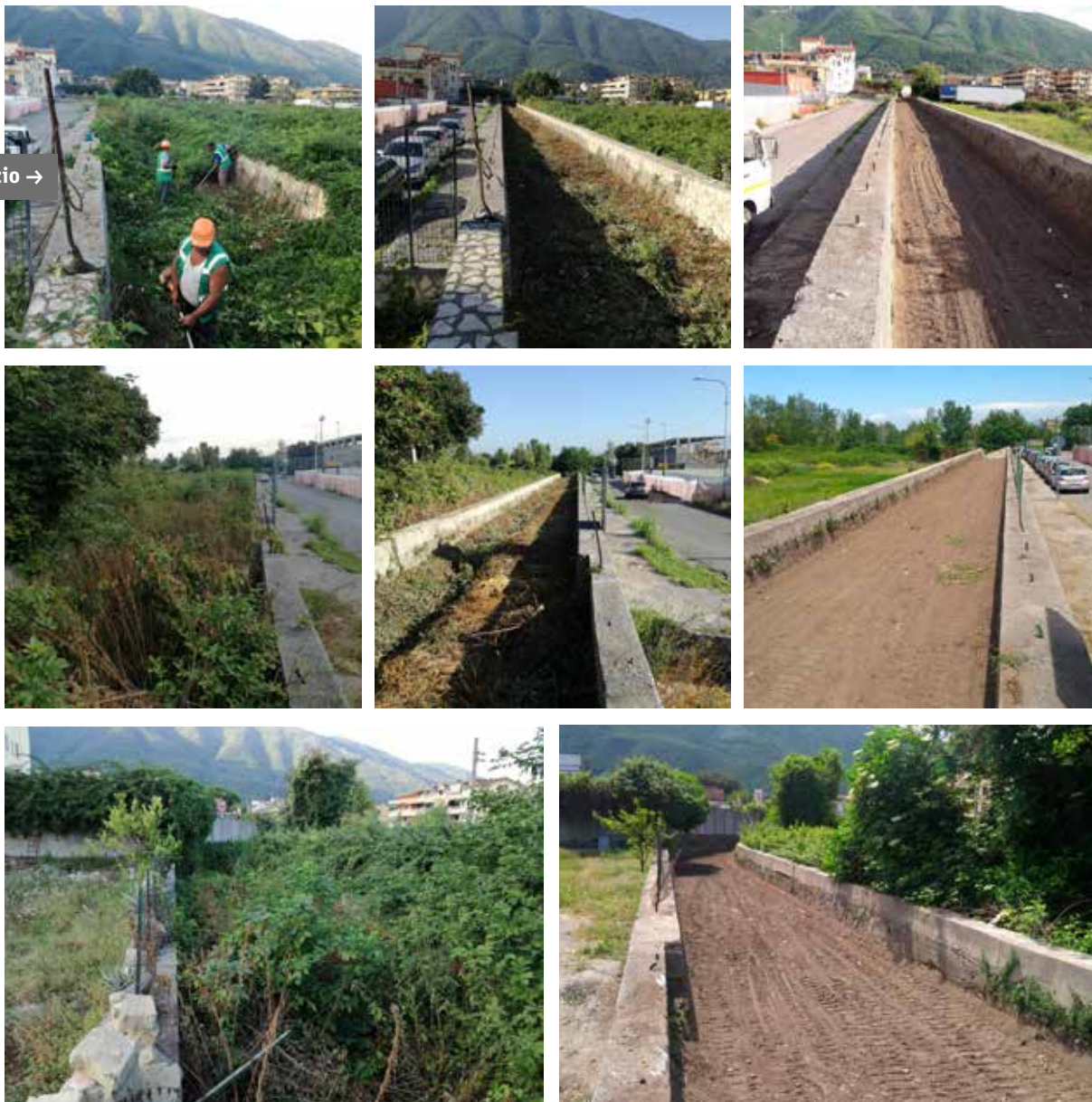
Collettore Santa Maria delle Grazie (tratto finale) - Comune di Angri Diserbo manuale del fondo alveo Ripristino sezioni idrauliche con rimozione, trasporto e conferimento in impianto autorizzato dei fanghi
