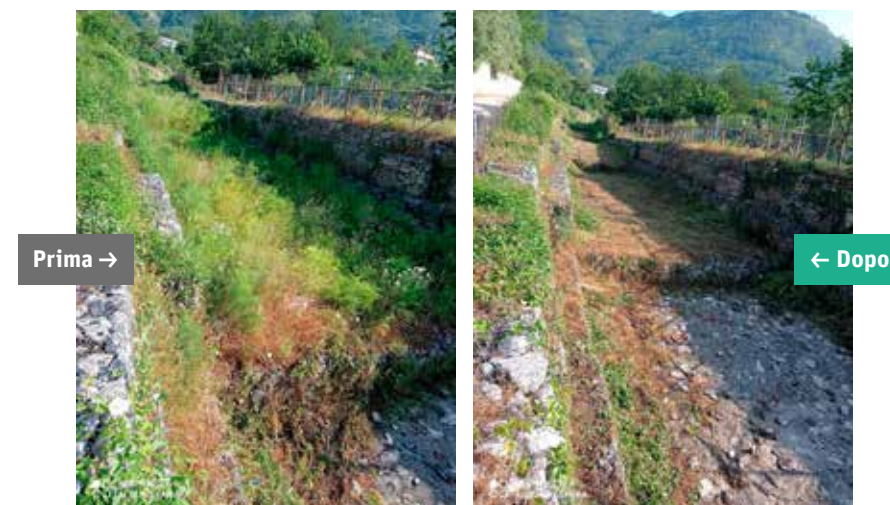
Torrente Lavinaio - Comuni di Bracigliano e Mercato San Severino Lavoro di sfalcio manuale e meccanico della vegetazione nel fondo alveo
