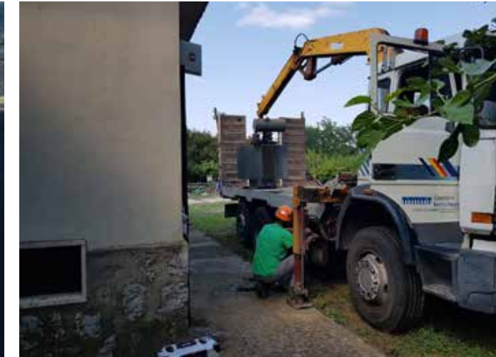
Sostituzione trasformatore MT/BT
