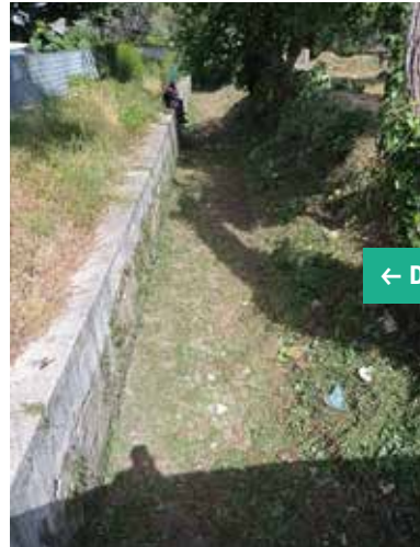
Collettore Roccapiemonte e diramatori - Comune di Roccapiemonte Lavoro di sfalcio manuale della vegetazione nel fondo alveo
