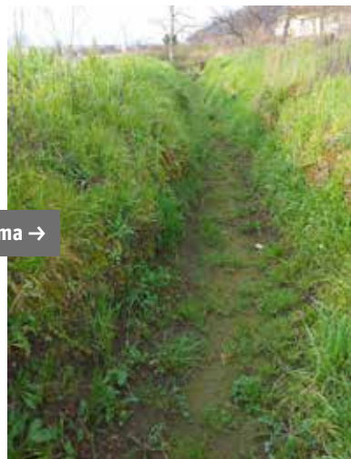
Canale Tufare - Comune di Castel San Giorgio Lavoro di sfalcio manuale della vegetazione nel fondo alveo e delle sponde
