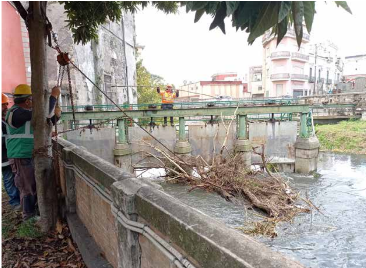
Presidio idraulico complesso delle paratoie sul fiume Sarno - Comune di Scafati Interventi periodici di disostruzione a tutela della pubblica incolumit*
