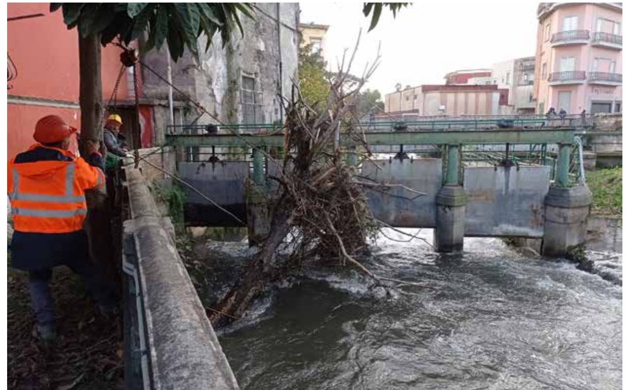
Presidio idraulico complesso delle paratoie sul fiume Sarno - Comune di Scafati Interventi periodici di disostruzione a tutela della pubblica incolumit*
