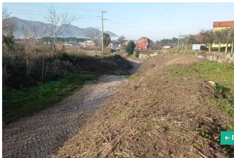
Torrente Calvagnola - Comune di Fisciano Lavoro di sfalcio meccanico della vegetazione nel fondo e sulle sponde
