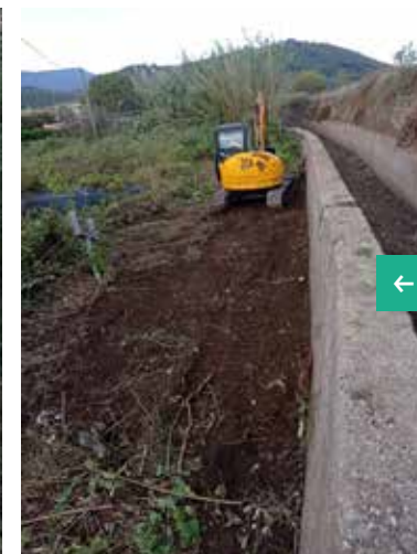
Canale Zanardelli - Comune di Roccapiemonte Diserbo meccanico e ripristino sezione idraulica con escavatore
