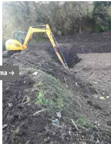
Vasca Coscia - Comune di Mercato San Severino Ripristino sezione idraulica con risagomatura sponde e fondo alveo con mezzi meccanici
