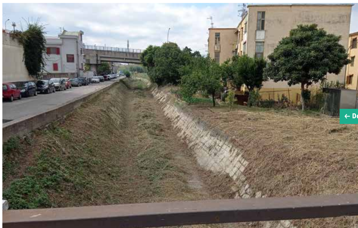
Canale Bottaro - Comune di Scafati (tratto iniziale Via Zara e Via Del Polverificio) Lavoro di sfalcio manuale della vegetazione nel fondo alveo e sulle sponde
