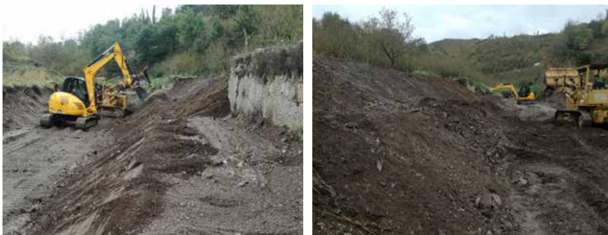
Torrente Calvagnola - Comune di Fisciano Ripristino sezioni idrauliche con risagomatura sponde e fondo alveo con mezzi meccanici
