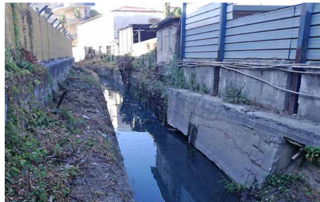
Canale Maestro - Comune di Castellammare di Stabia Lavoro di sfalcio manuale della vegetazione nel fondo alveo e sulle sponde Raccolta, rimozione e smaltimento di rifiuti abbandonati nelle aree di pertinenza
