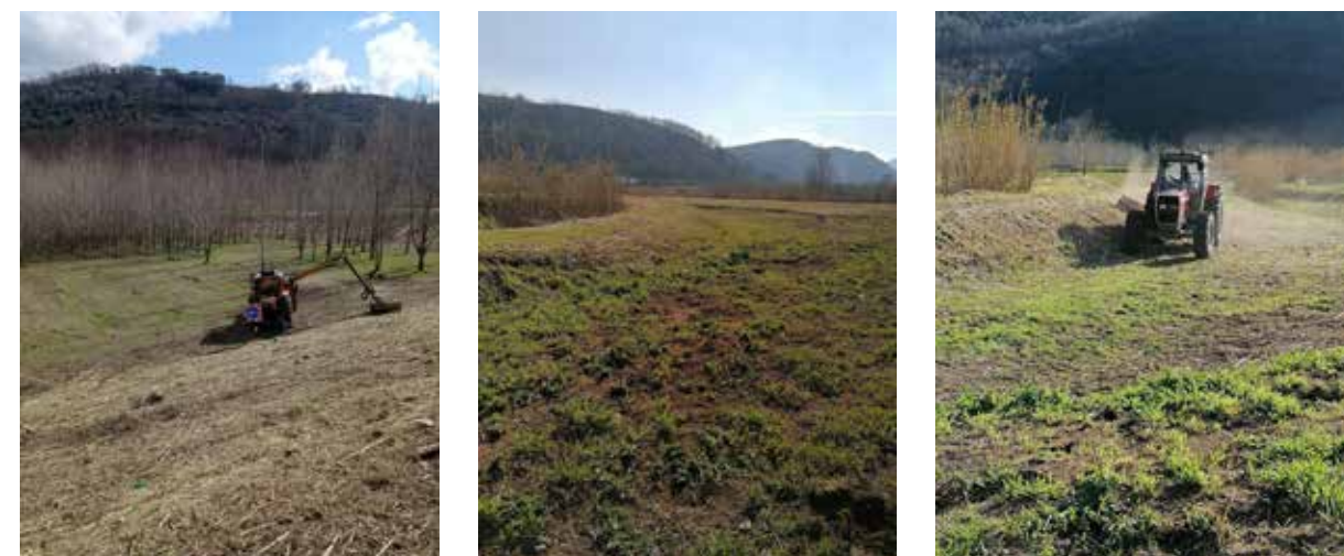
Vasche Ciorani - Comune di Mercato San Severino Diserbo meccanico del fondo vasca e degli argini con trattore dotato trincia
