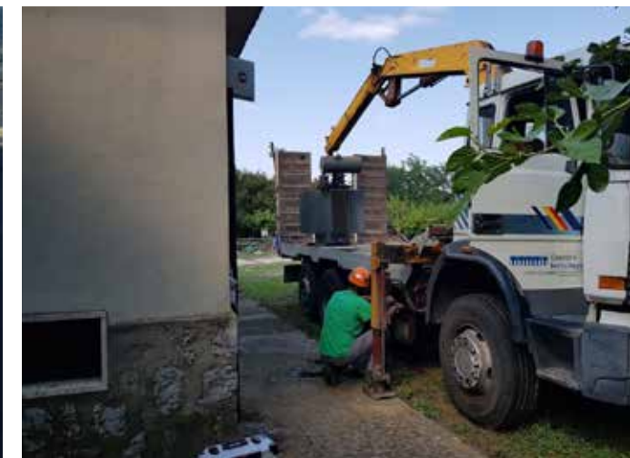
Sostituzione trasformatore MT/BT
