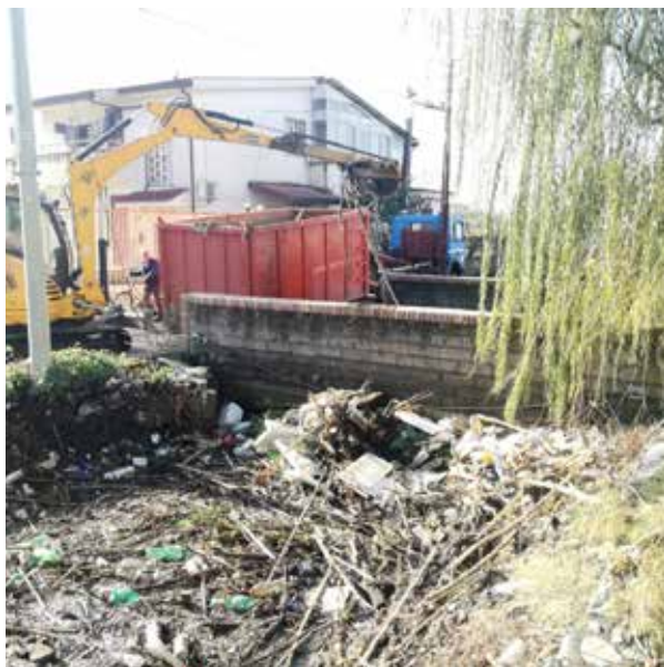
Canale Fosso Imperatore (tratto finale) - Comuni di San Valentino Torio e San Marzano sul Sarno Rimozione di rifiuti abbandonati abusivamente in alveo e trasporto presso impianti autorizzati
