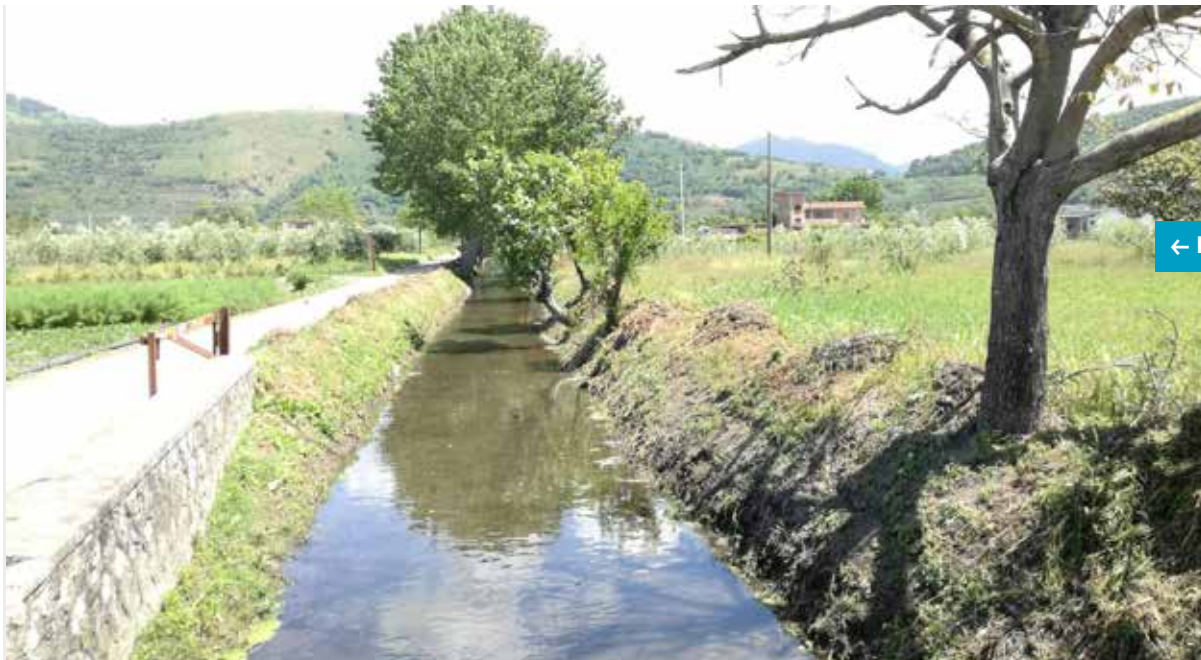
Canale Pennacchio - Comune di Nocera Inferiore Diserbo manuale e meccanico del fondo alveo e delle sponde
