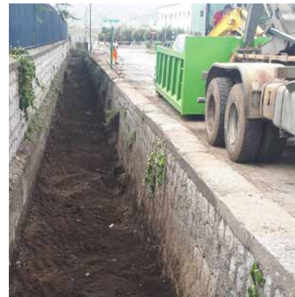
Canale Pietraperciata - Comune di Castel San Giorgio Lavori con mezzi meccanici per il ripristino dell'officiosità idraulica
