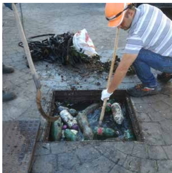
Canale di Via Nuova Lavorate - Comune di Sarno Disostruzione e pulizia pozzetti d'ispezione Raccolta e smaltimento rifiuti presso ditta convenzionata
