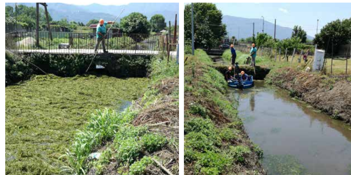
Controfosso Destro del fiume Sarno - Comune di Scafati Lavori di diserbo manuale delle sponde Taglio delle erbe acquatiche con motobarca munita di barra falciante
