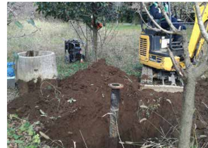
Installazione nuovo idrante
