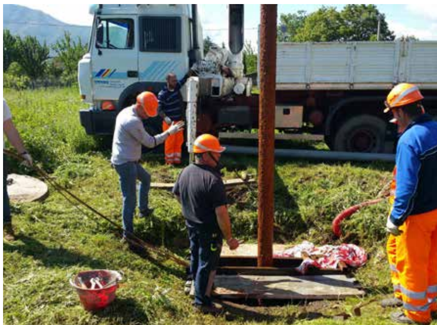
Eduzione elettropompa per manutenzione ordinaria
