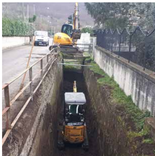
Canale Nocelleto - Comune di Mercato San Severino Lavori con mezzi meccanici per il ripristino dell'officiosità idraulica
