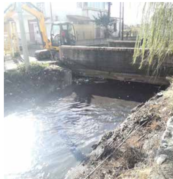
Canale Fosso Imperatore (tratto finale) - Comuni di San Valentino Torio e San Marzano sul Sarno Rimozione di rifiuti abbandonati abusivamente in alveo e trasporto presso impianti autorizzati
