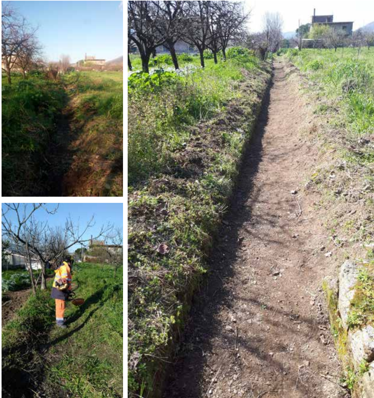
Canale Salice - Comune di Castel San Giorgio Sfalcio manuale delle erbe infestanti del fondo e delle sponde Ripristino della sezione idraulica
