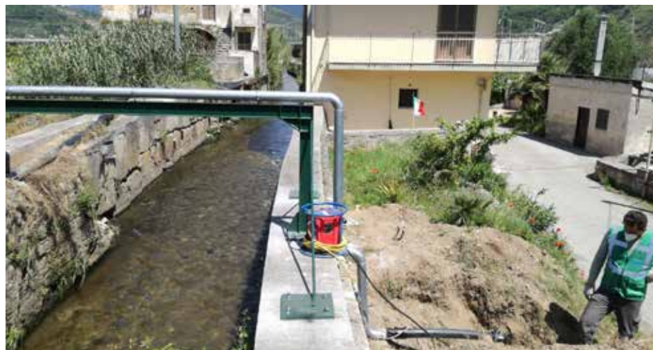
Realizzazione di ponte tubo sul torrente Casarzano
