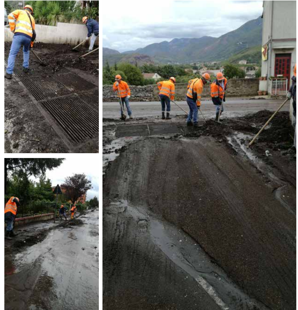
Griglie San Cipriano - Comune di Montoro Disostruzione manuale delle griglie e rimozione dei sedimenti depositatisi nei pressi dell'opera idraulica di intercettazione
